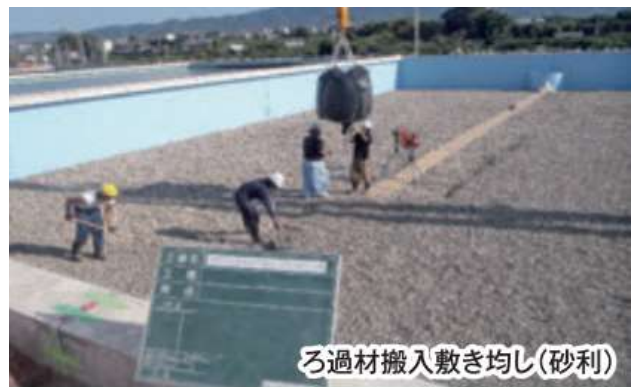
有孔煉瓦敷き均し
